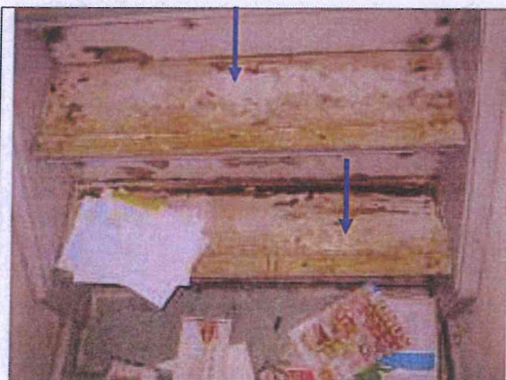
Foto 1: vloerzeilresten op traptreden trap nr. 1 e verdieping M1 - geen asbest aangetroffen
