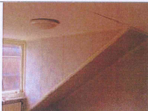
Foto 4: dakraam en plafond geen asbest aangetroffen
