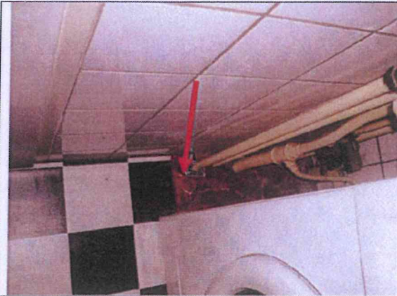
Foto 1: Keuken, Paramaribostraat 52 Vloerzeil M1 - Asbesthoudend
